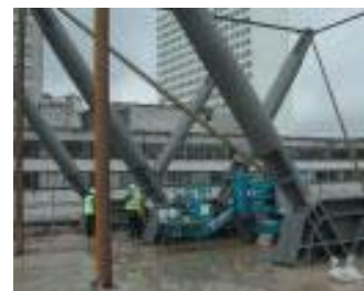
Наклонные трубчатые колонны
