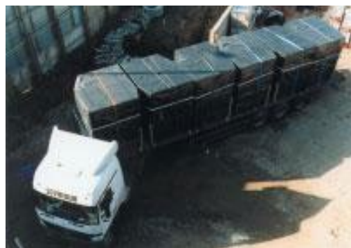
Доставка модулей туалетов и ванных комнат на строительную площадку
