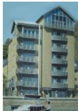
Вид на жилой комплекс со стороны реки
