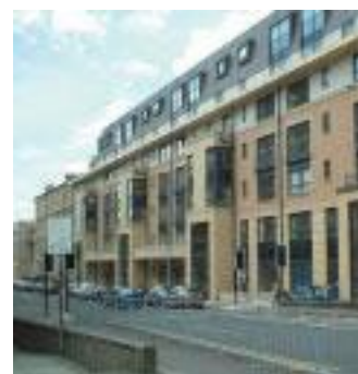
Вид на фасад здания с улицы
