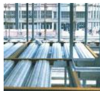
Пролетные строения, поддерживаемые балками ASB
