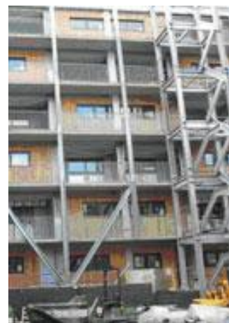
Монтаж переходной галереи
