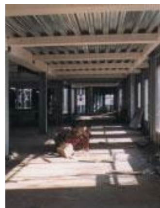
Железобетонный цоколь, образующий первый этаж
