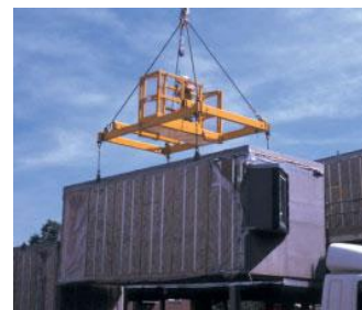
Подъем модуля на место установки с использованием люльки
