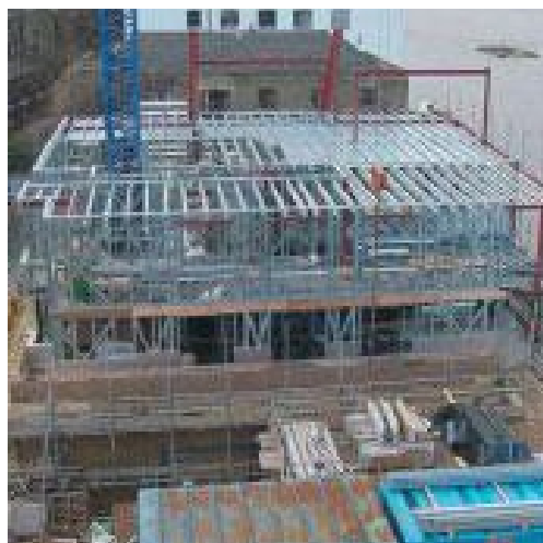
Монтаж панелей Metframe
