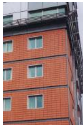
Фасад, облицованный керамической плиткой
