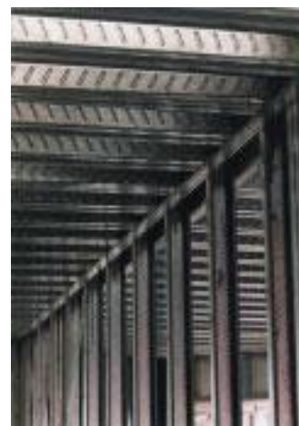
Внутренний каркас с уложенными на него настилами перекрытий
