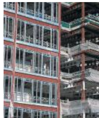
Применение легких стальных каркасных стен
