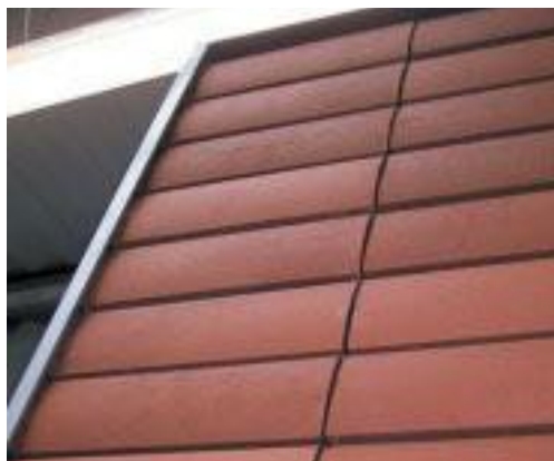
Фасад типа «дождевой экран», облицованный керамической плиткой
