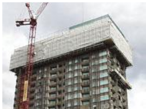
Возведение надстройки на крыше старого здания
