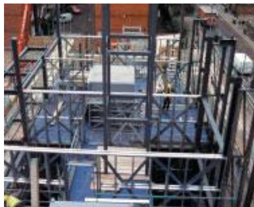
Монтаж легких стальных каркасов
