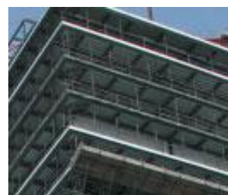
Нижняя сторона перекрытия
