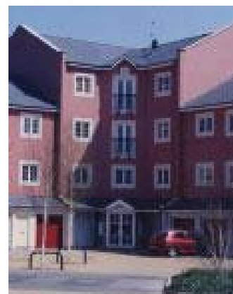
Здание из трех и четырех этажей, возведенное с использованием конструкций Surebuild
