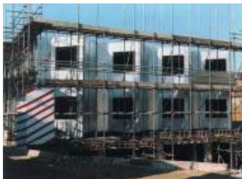
Блоки номеров перед облицовкой фасада
