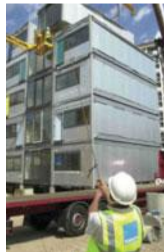
Монтаж модулей
