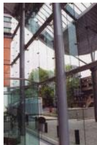
Навес над входом в здание с опорами из трубчатых колонн
