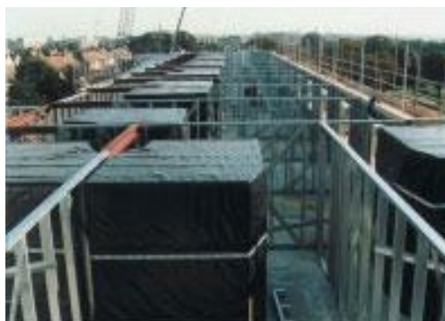
Смонтированные модули туалетов и ванных комнат
